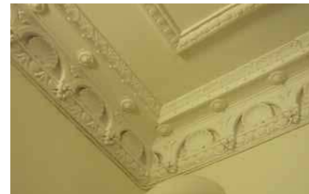
Ursprungliga stucaturer finns bevarade, främst i byggnadsdelen mot Nybrogatan.
