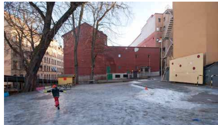
Riddaren 18, fasad mot Riddaren 6 i väster. Projektering pågår för en ny skolbyggnad på den befintliga skolgården i förgrunden.
