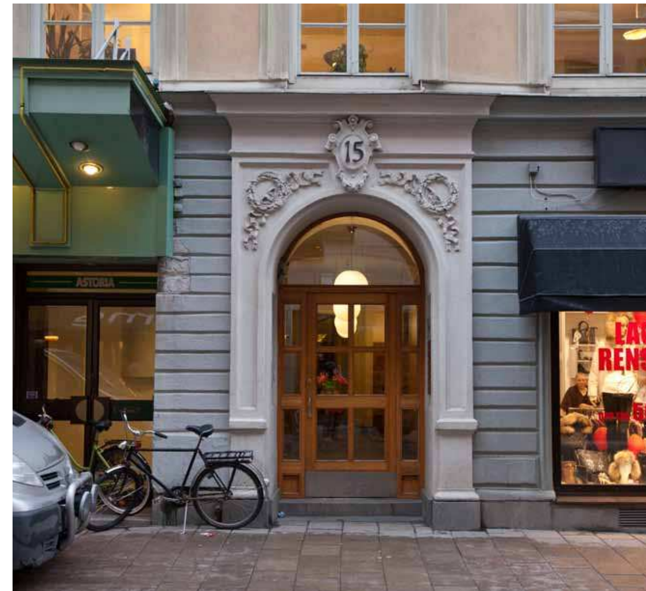
Befintlig portal till bostadsentrén vid Nybrogatan.
