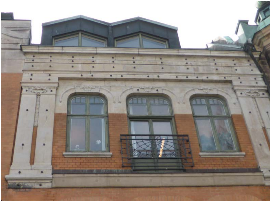
| Smidesrücke, stenpartier i gott skick och kopparplåt som takmaterial bevaras.
