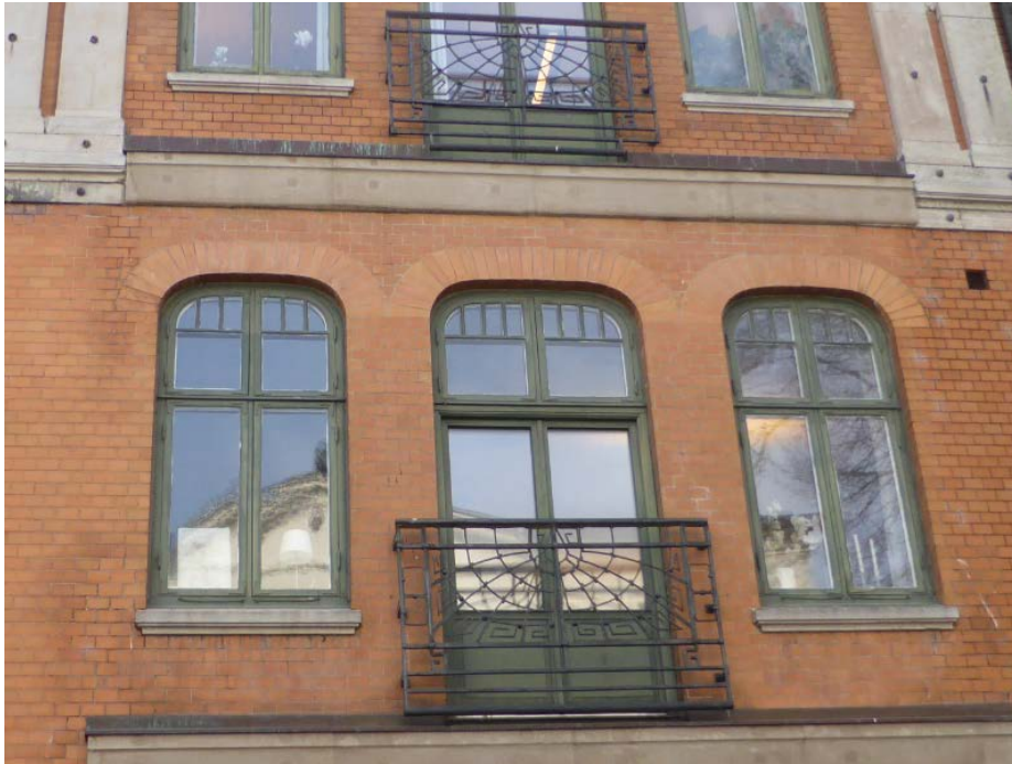
| Fönster samt tegelfasad som är i gott skick och som ska bevaras.
