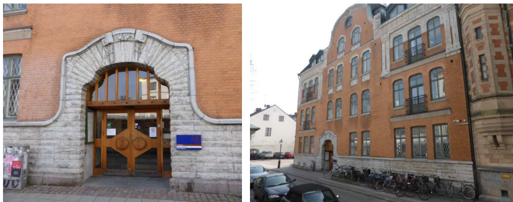
Jugendbyggnaden i tegel med dess nyare entré på Stora Algatan 4.
